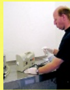
Der Kompressor wird separat im Vorraum der Schmutzschleuse gereinigt und desinfiziert.
